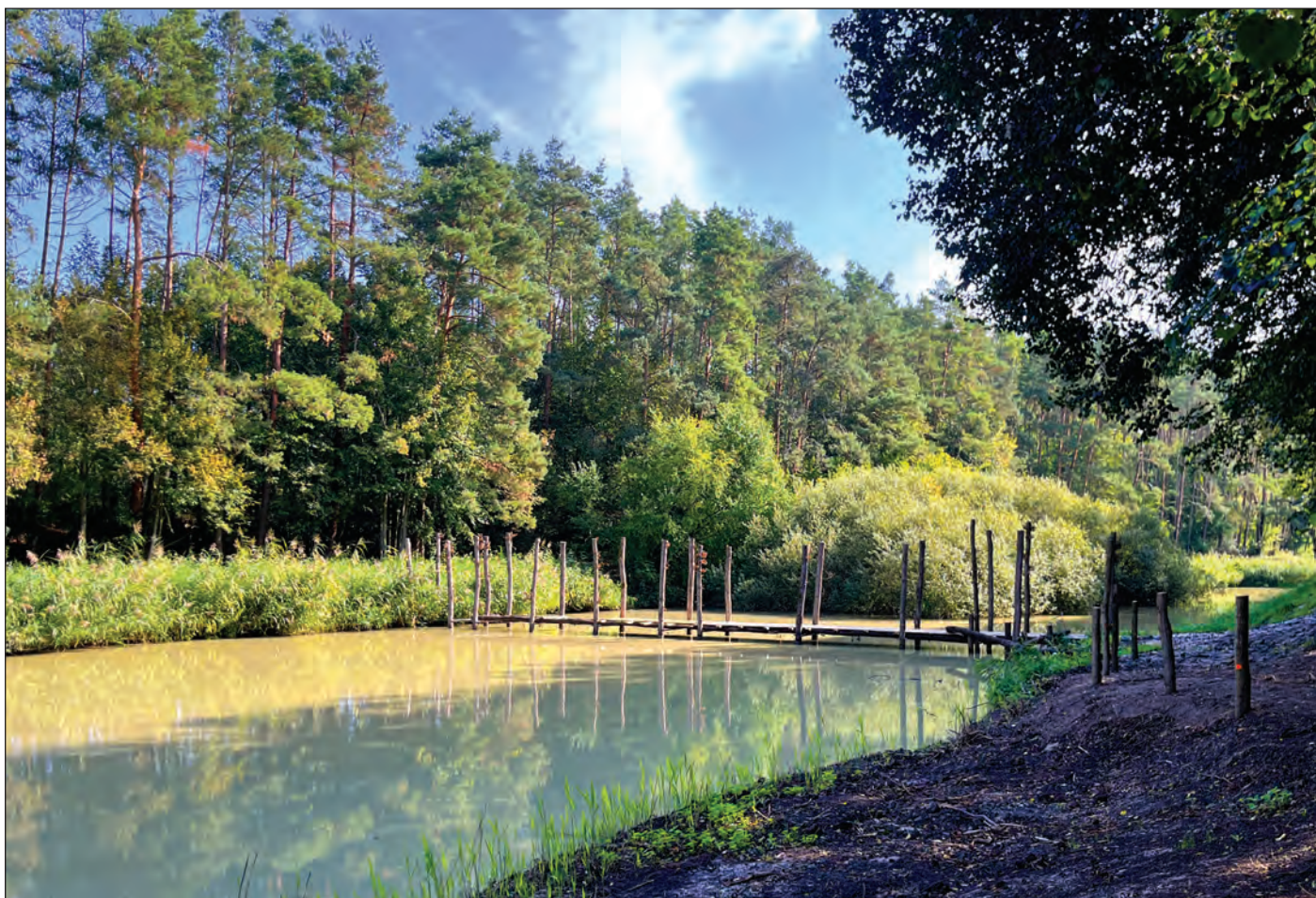
Na Dolním rybníku Na Holi vzniká nová lávka
