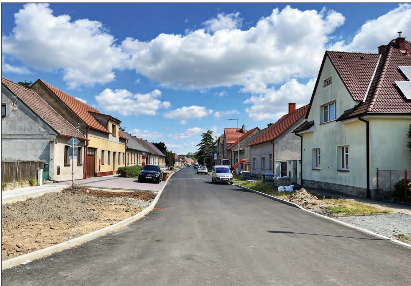
Během léta pokračovala rekonstrukce Boleslavské a Tyršovy ulice
