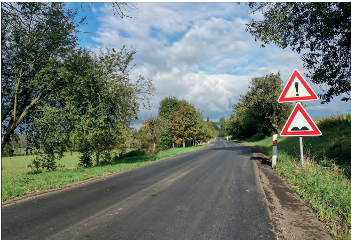
V září byla nově vyasfaltována silnice spojující Nové Zámky a Leděčky
