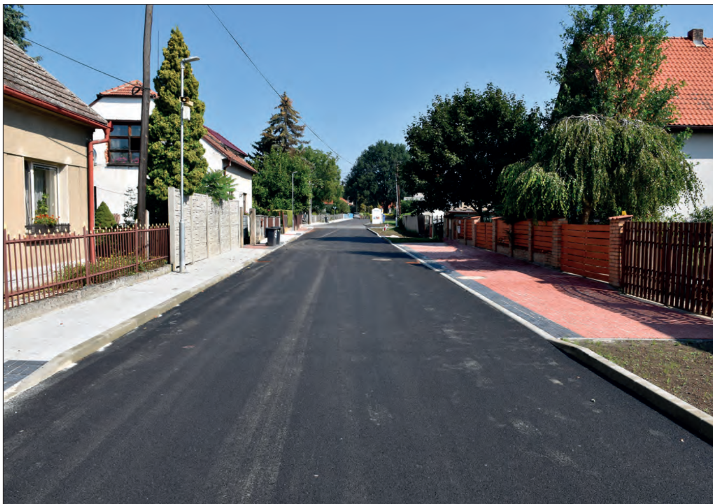
Na konci července byla dokončena rekonstrukce Školní ulice
