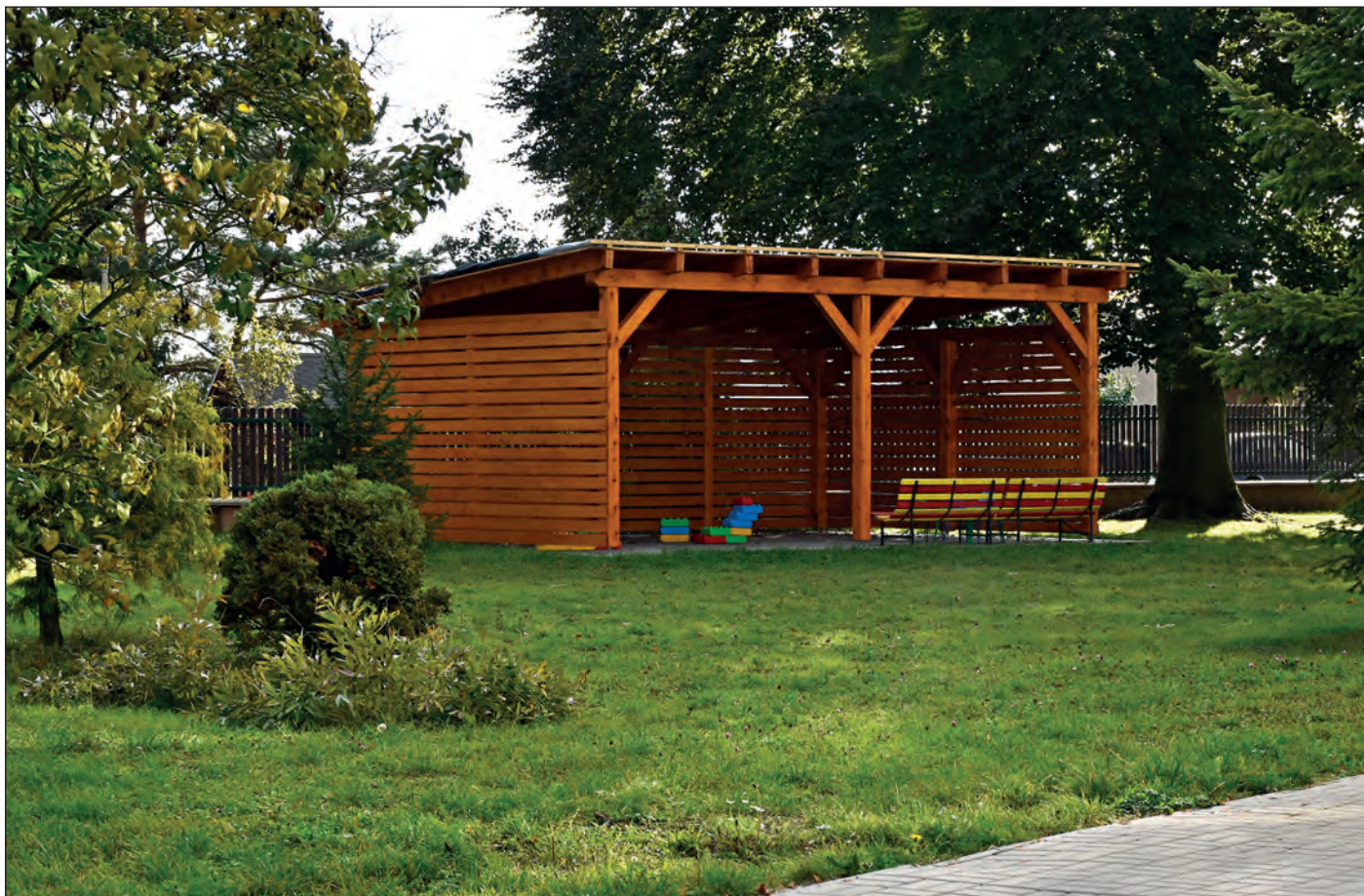
Během léta byla v zahradě mateřské školy postavena venkovní učebna
