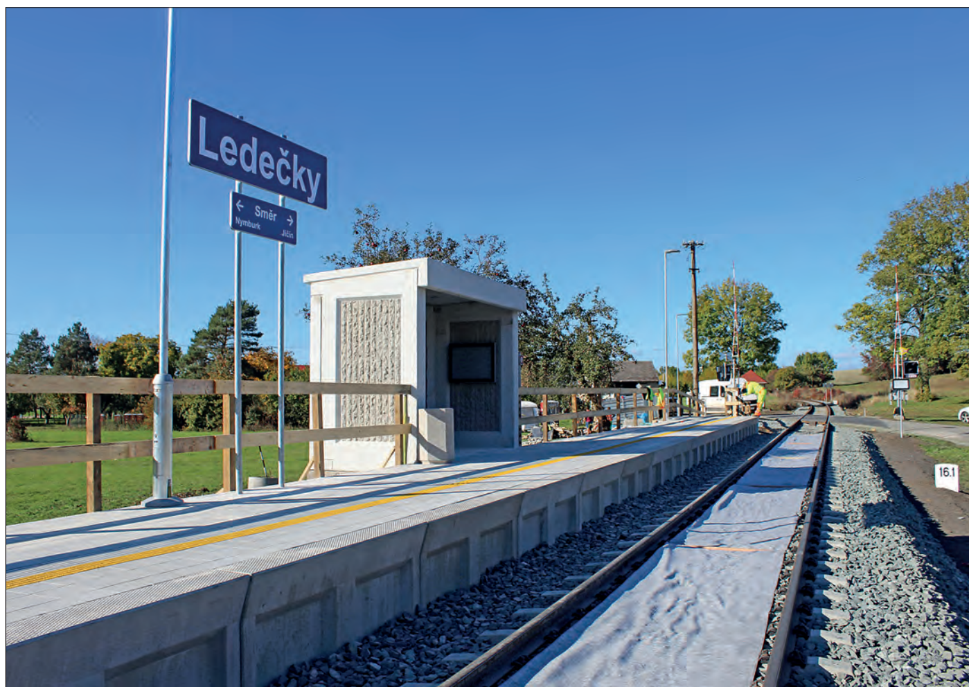
Od konce září do 7. října probíhala rekonstrukce nástupiště a železničního přejezdu v Ledečkách
