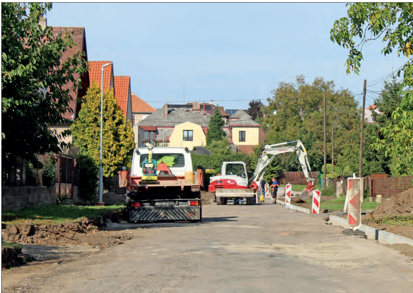
Oprava Rajmanovy ulice byla zahájena v polovině září
