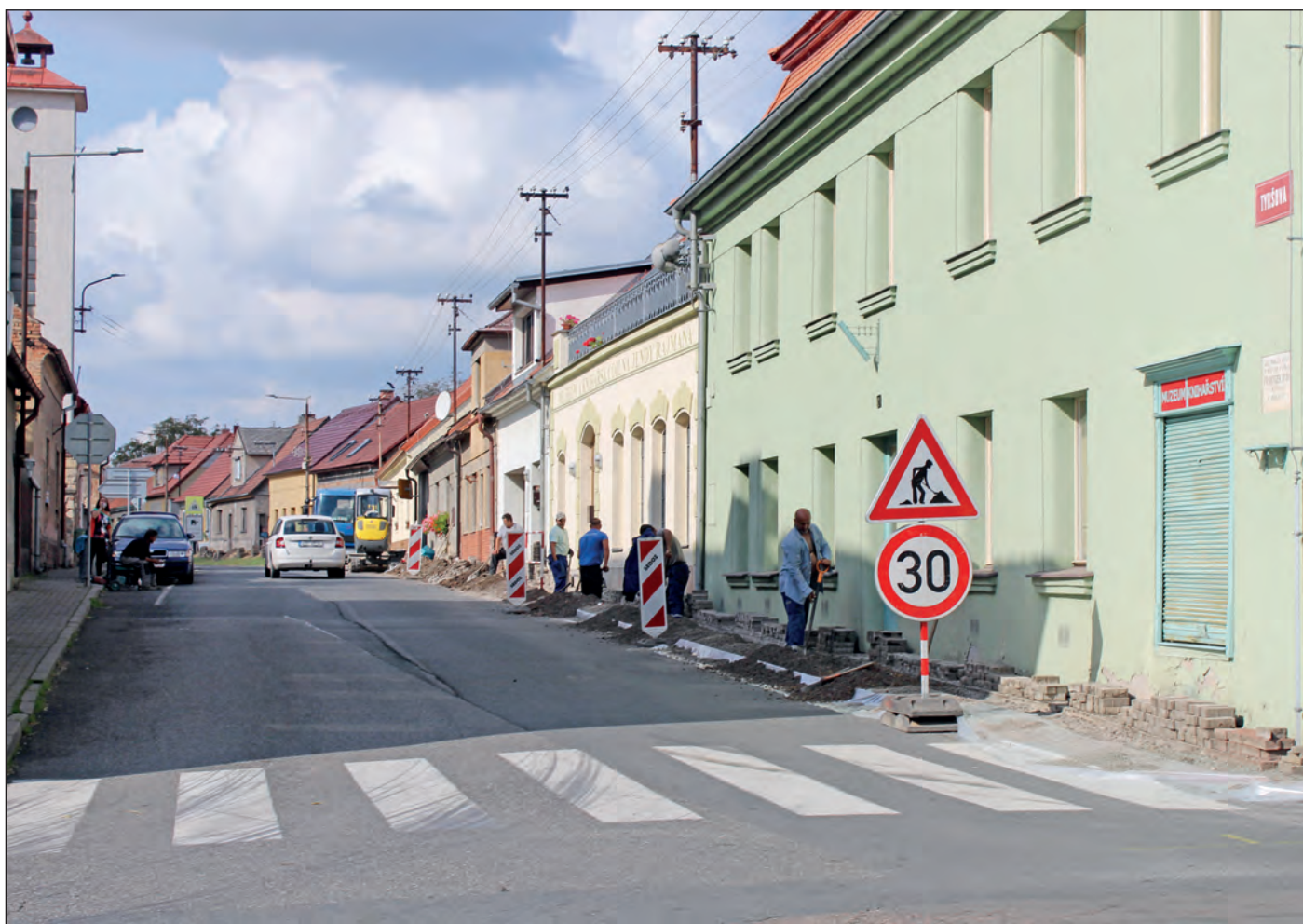
Koncem září firma ČEZ zahájila přeložku elektrického vedení v Tyršově ulici
