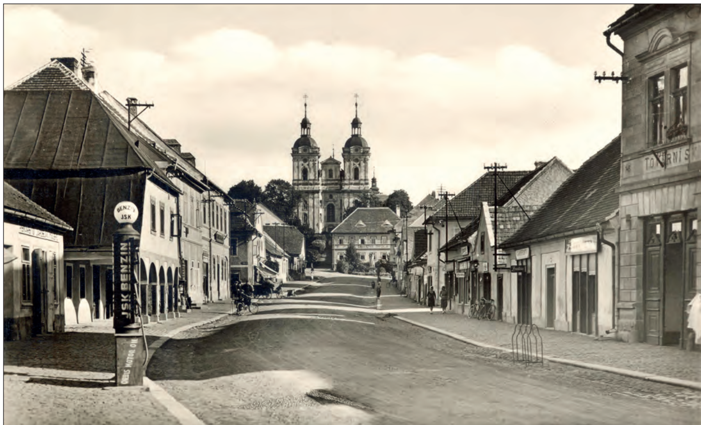
Živnostensko-obchodnická záložna sídlila v dnes již neexistujícím domě čp. 101 – druhý zprava (archiv Nadačního fondu Jendy Rajmana)
