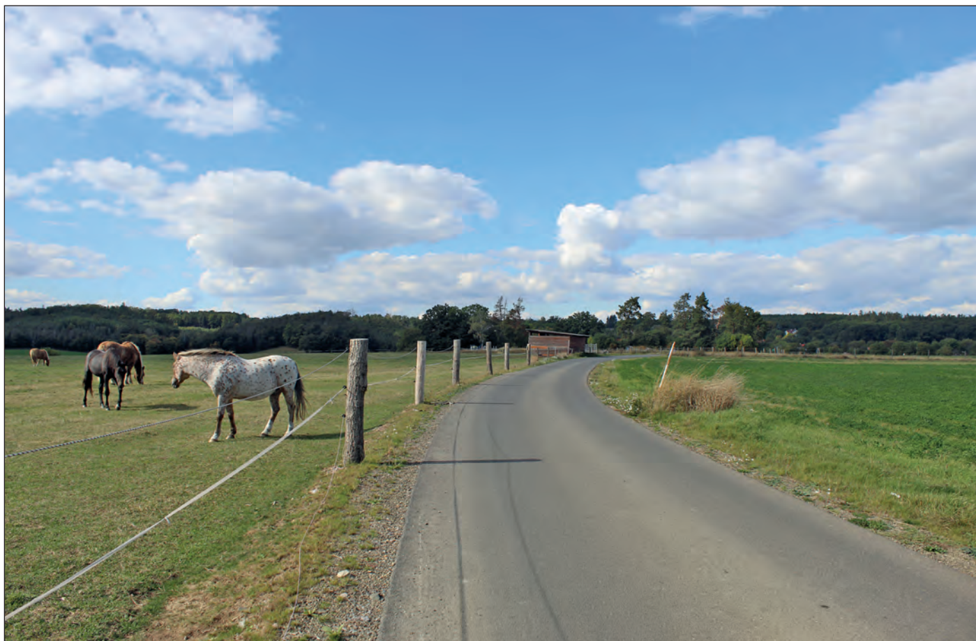
Během léta byla dokončena realizace projektu Polní cesty Sovenice, Seletice, Doubravany, která byla financována Ministerstvem zemědělství ČR a Evropskou unií. V září byla zahájena úprava polní cesty směřující od Hájku do Doubravan
