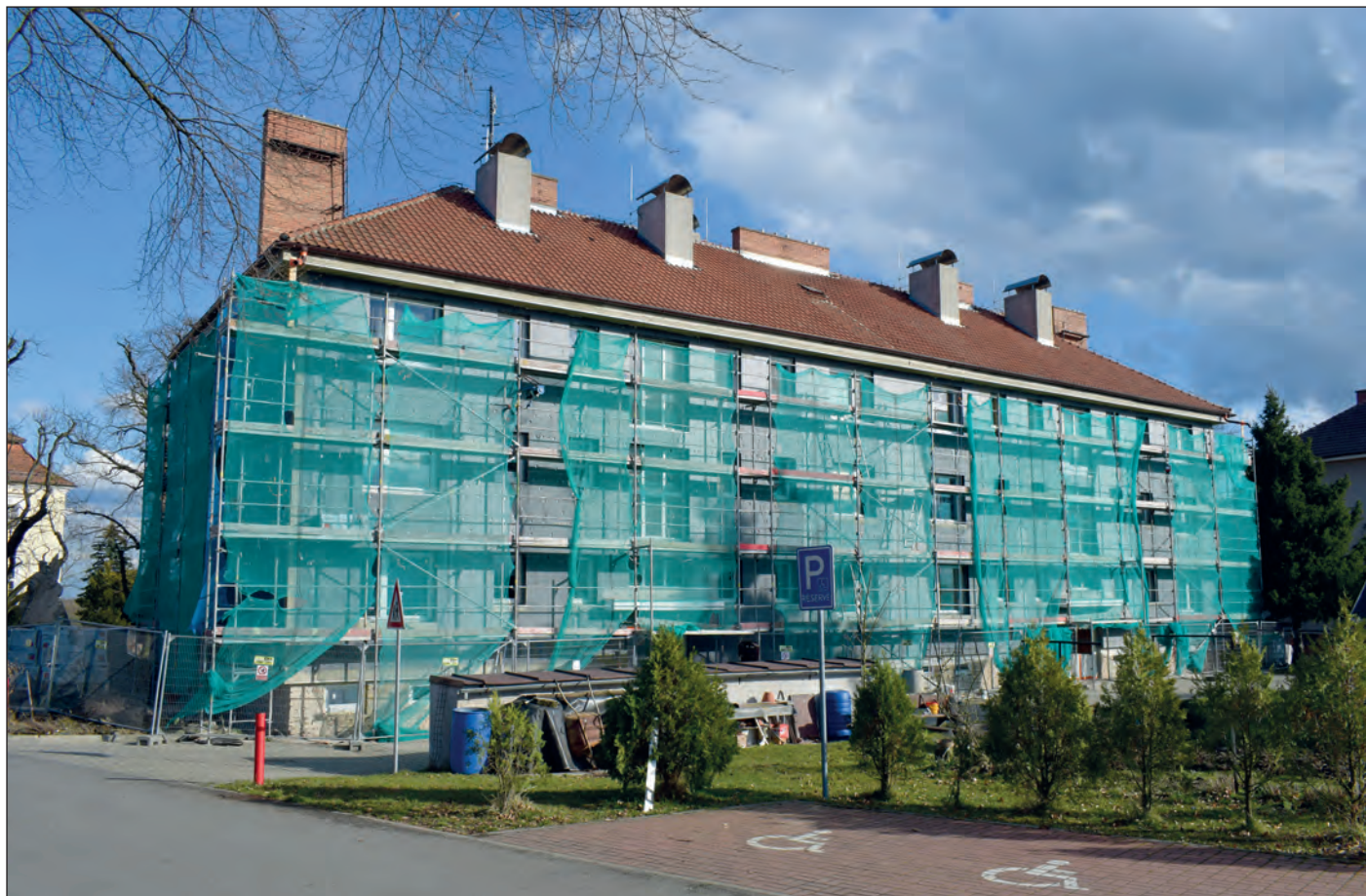
Ve druhé polovině března byla zahájena rekonstrukce (zateplení) bytovky v Zahradní ulici
