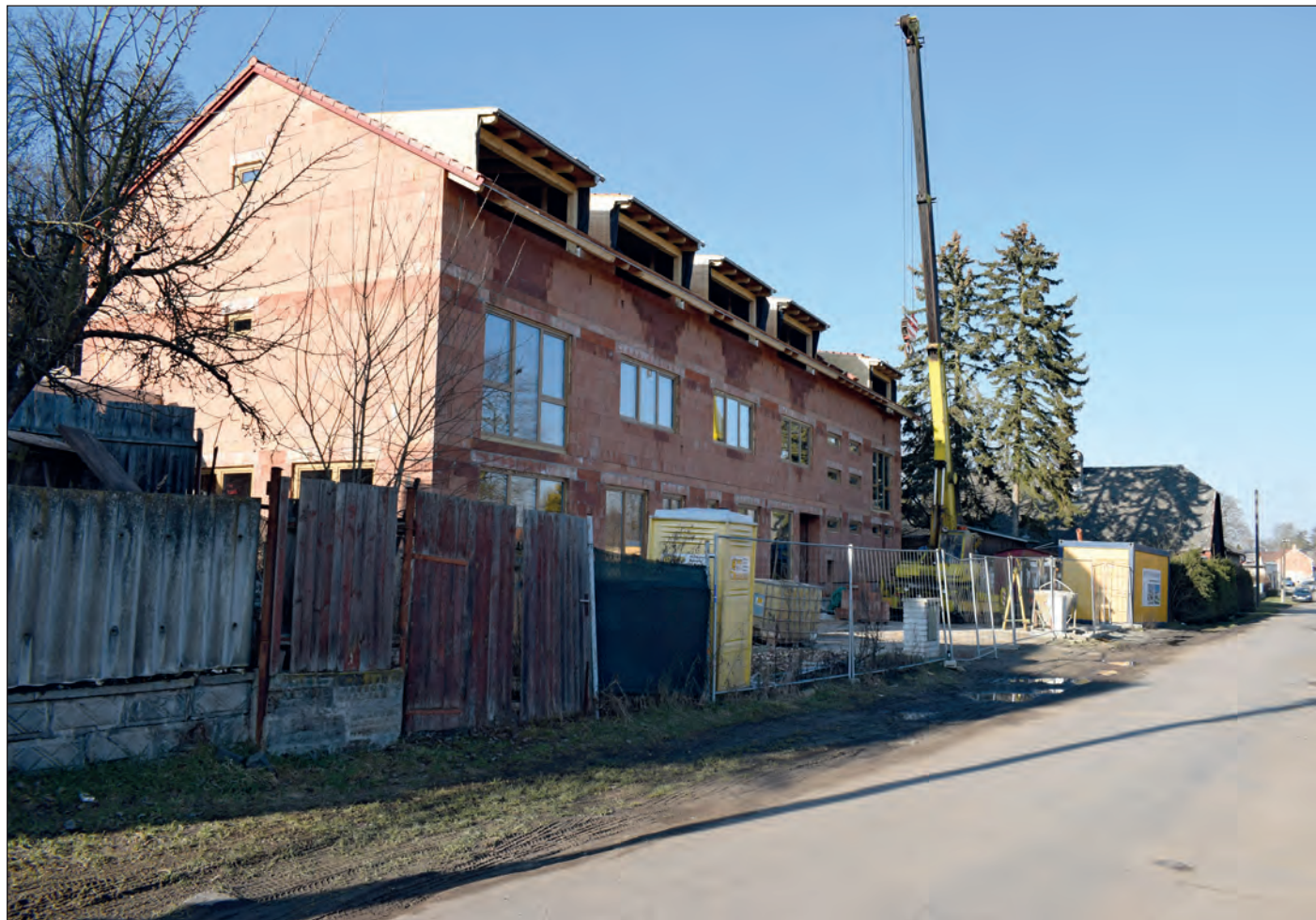
V Lindnerově ulici pokračuje soukromý investor ve výstavbě bytového domu pro seniory
