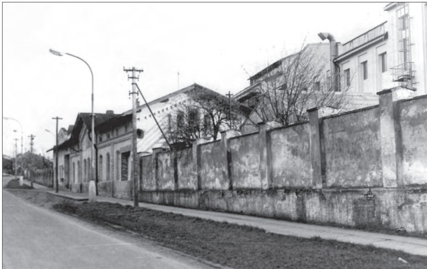
Vstupní budova do cukrovaru nedlouho před demolicí na snímku z konce 60. let 20. století (archiv města Rožďalovice)
