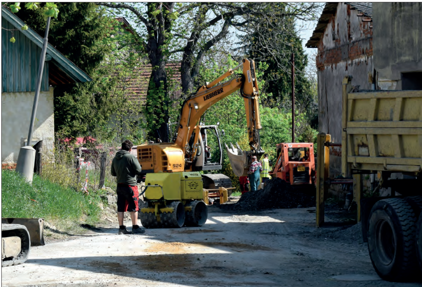
Koncem dubna byla provedena pokládka kanalizace v ulici U Barborky mezi zámekem a hřbitovem, během dalších dvou měsíců pak pokračovala její výstavba zavedením jednotlivých přípojek v této části města a ve spádových obcích
