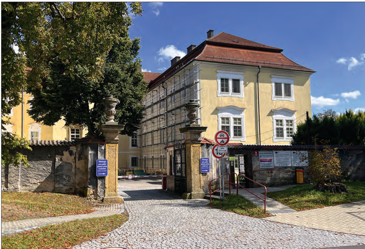
Domov Rožďalovice začal během léta provádět rekonstrukci fasády na budově zámku
