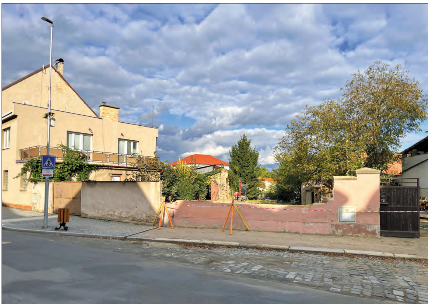
Koncem září provedl vlastník demolici domu čp. 99
