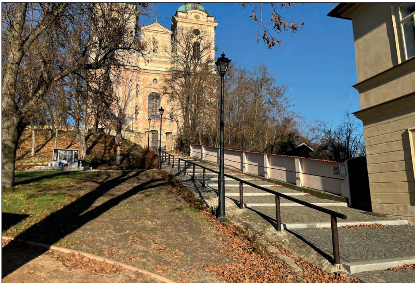
Zrenovované schody ke kostelu byly na konci října osazeny zábradlím
