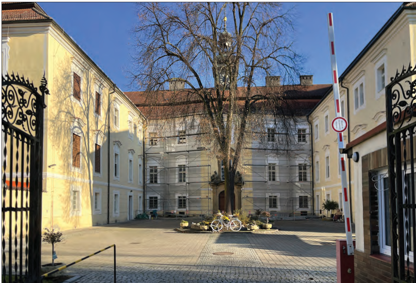
Domov Rožďalovice pokračoval během podzimu s obnovou fasády na zámecké budově
