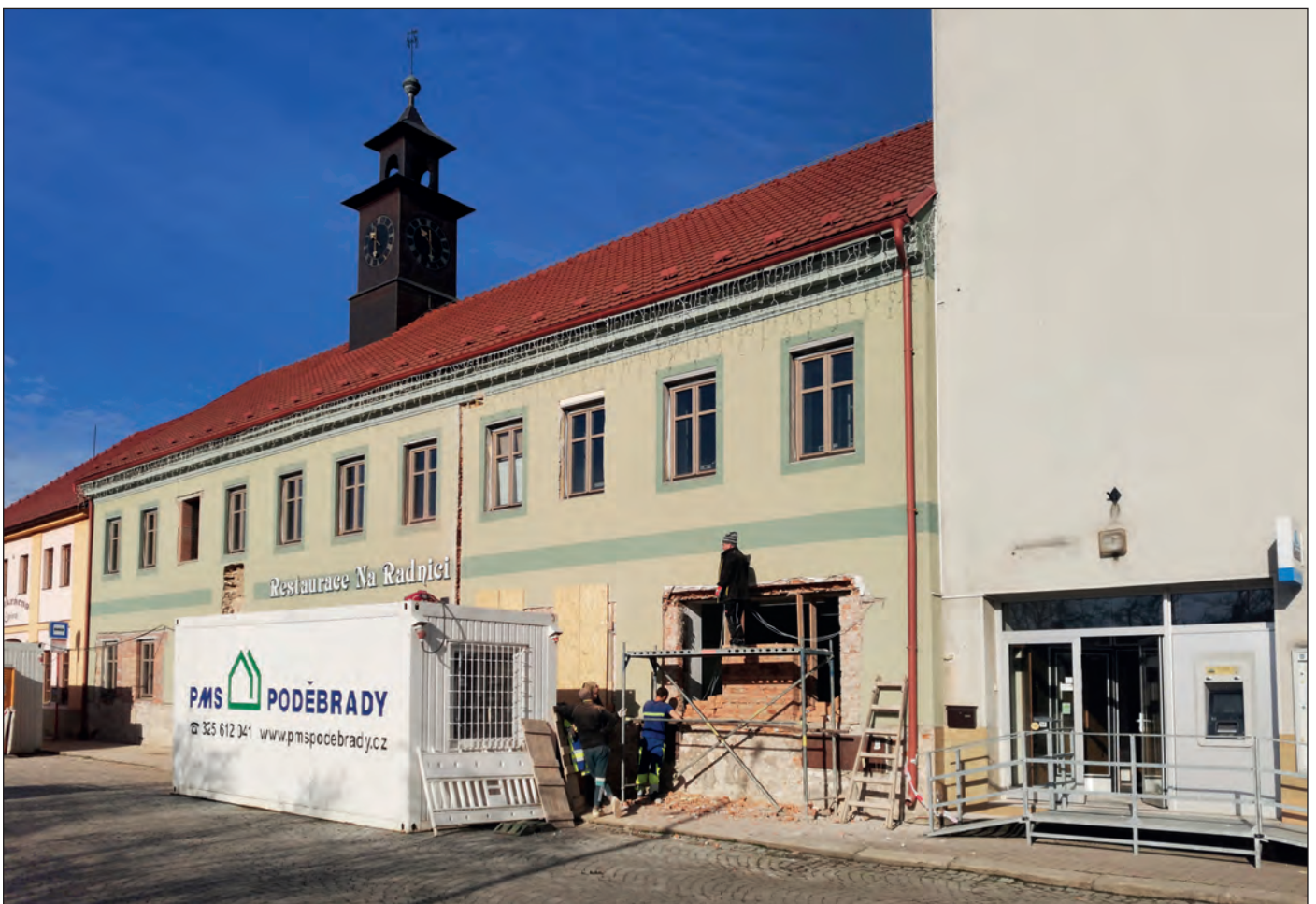
Budova radnice prochází rozsáhlou rekonstrukcí
