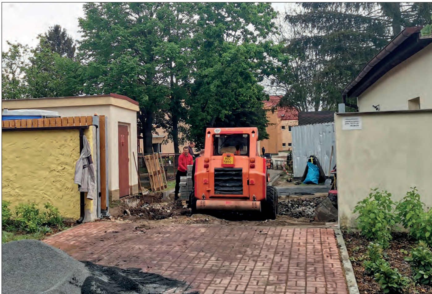
Domov Rožďalovice nechal v areálu kláštera opravit zadní přístupovou cestu a osadil vchod novými vraty
