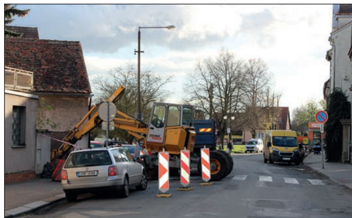
Koncem října byla částečně omezena doprava v Husově ulici z důvodu výstavby vodovodní přípojky
