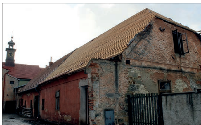
Byla zahájena oprava střechy hospodářské budovy za úřadem
