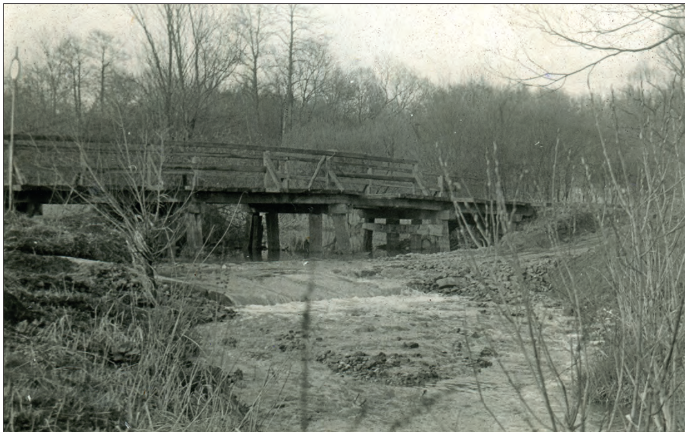
Dřevěný most na Bučici krátce před rekonstrukcí
