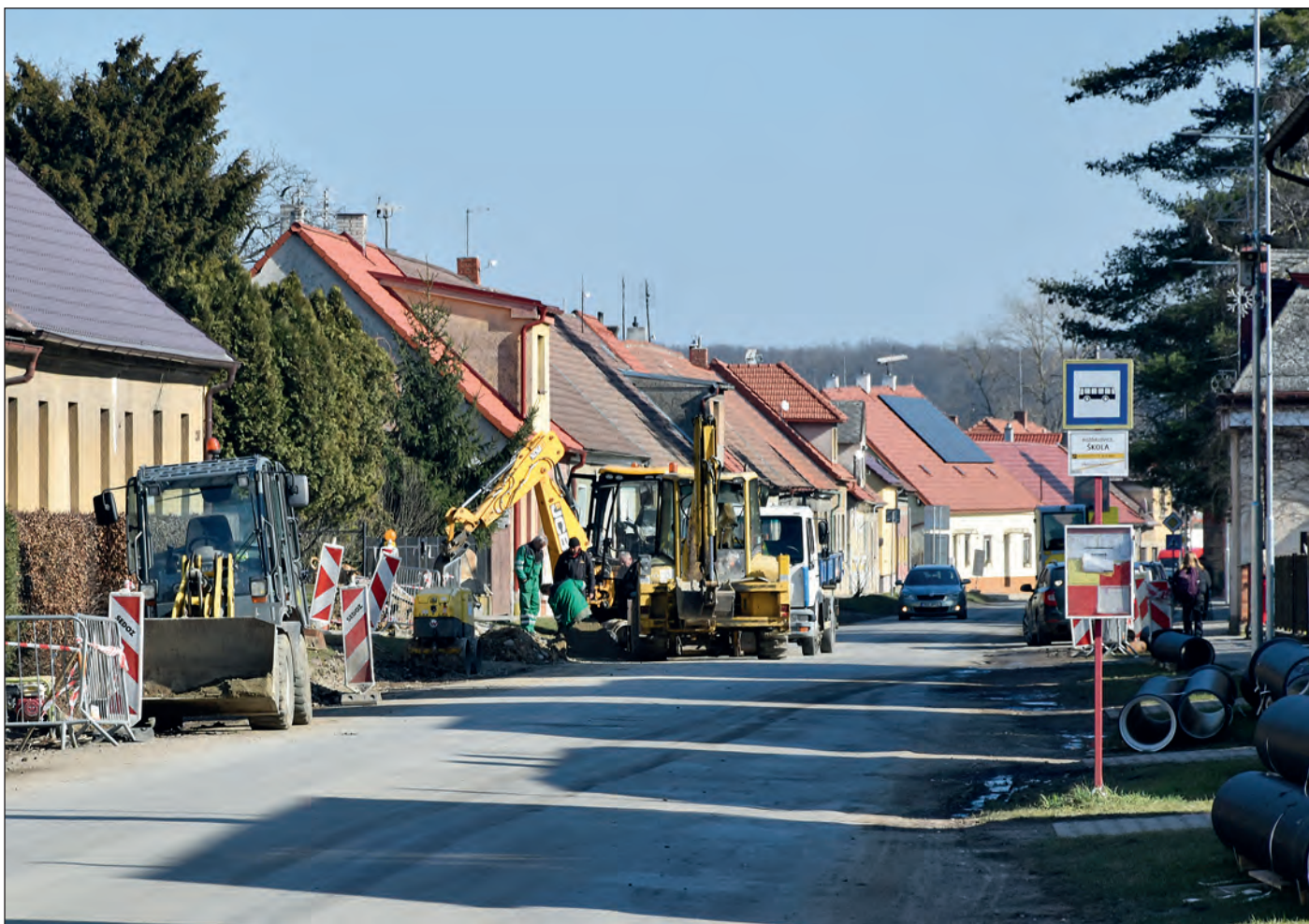
Od začátku roku provádí VaK Nymburk pokládku nového kanalizačního potrubí v Tyršově ulici
