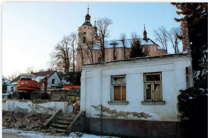
Začátkem roku byla provedena demolice domu čp. 137 v Lindnerově ulici
