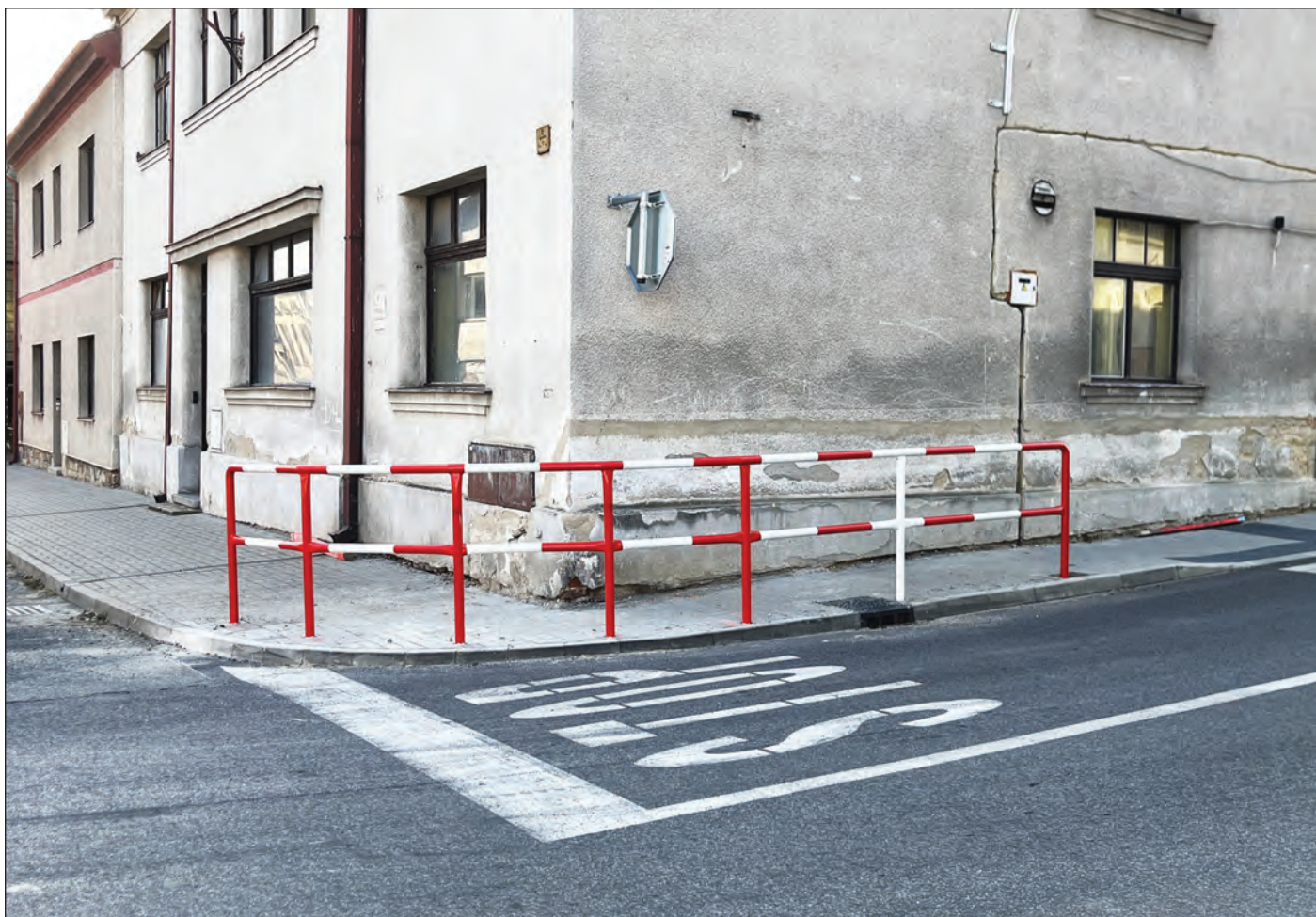
V Tyršově ulici byly v říjnu instalovány nové bezpečnostní prvky
