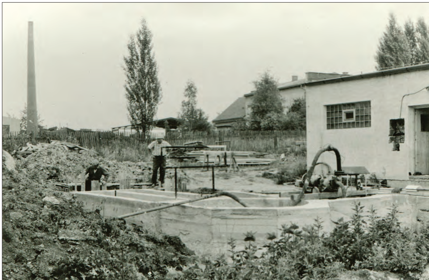
Výstavba čističky odpadních vod v Záměstí probíhala v letech 1977–1984
