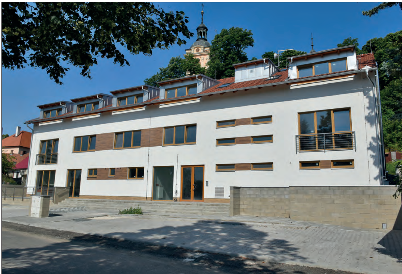
Stavba bytového domu pro seniory v Lindnerově ulici je před kolaudací
