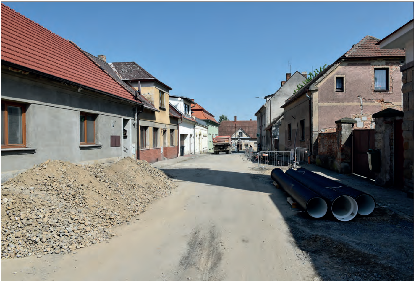
Začátkem léta Vodovody a kanalizace Nymburk dokončily pokládku nového kanalizačního potrubí v Tyršově ulici
