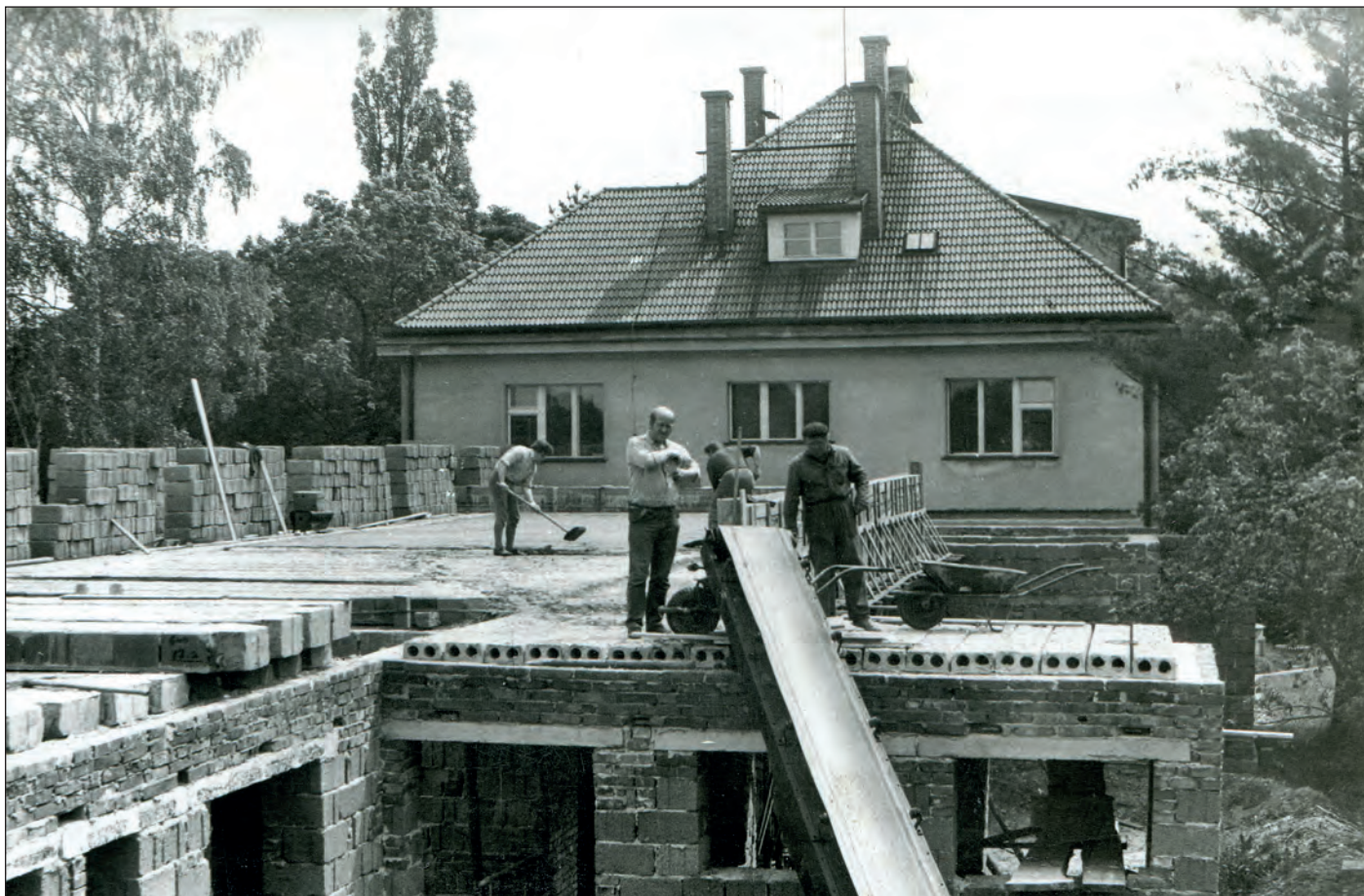
Na stavbě mateřské školy se pracovalo brigádně každý víkend
