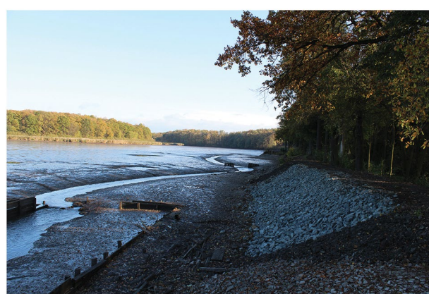
Po říjnovém výlovu byla provedena oprava bráže Bučického rybníka. Zlepšila se její těsnost a byla upravena koruna bráže
