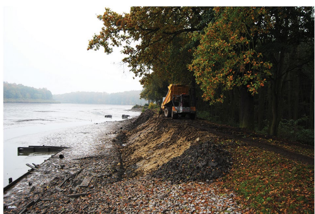
Po říjnovém výlovu byla provedena oprava bráže Bučického rybníka. Zlepšila se její těsnost a byla upravena koruna bráže
