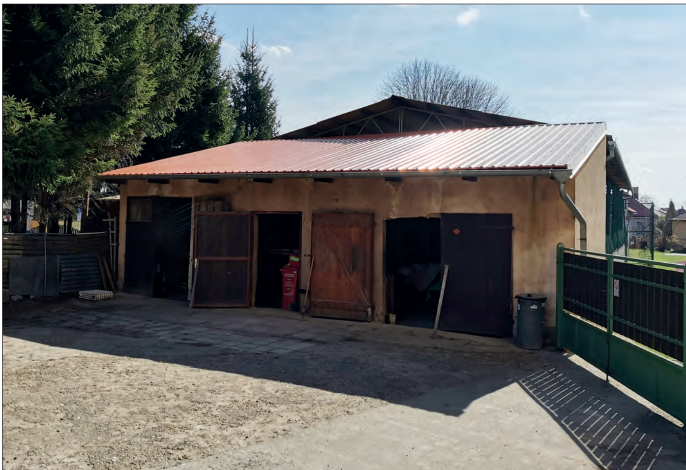
Začátkem března byla zrekonstruována střecha hospodářské budovy na školním dvoře
