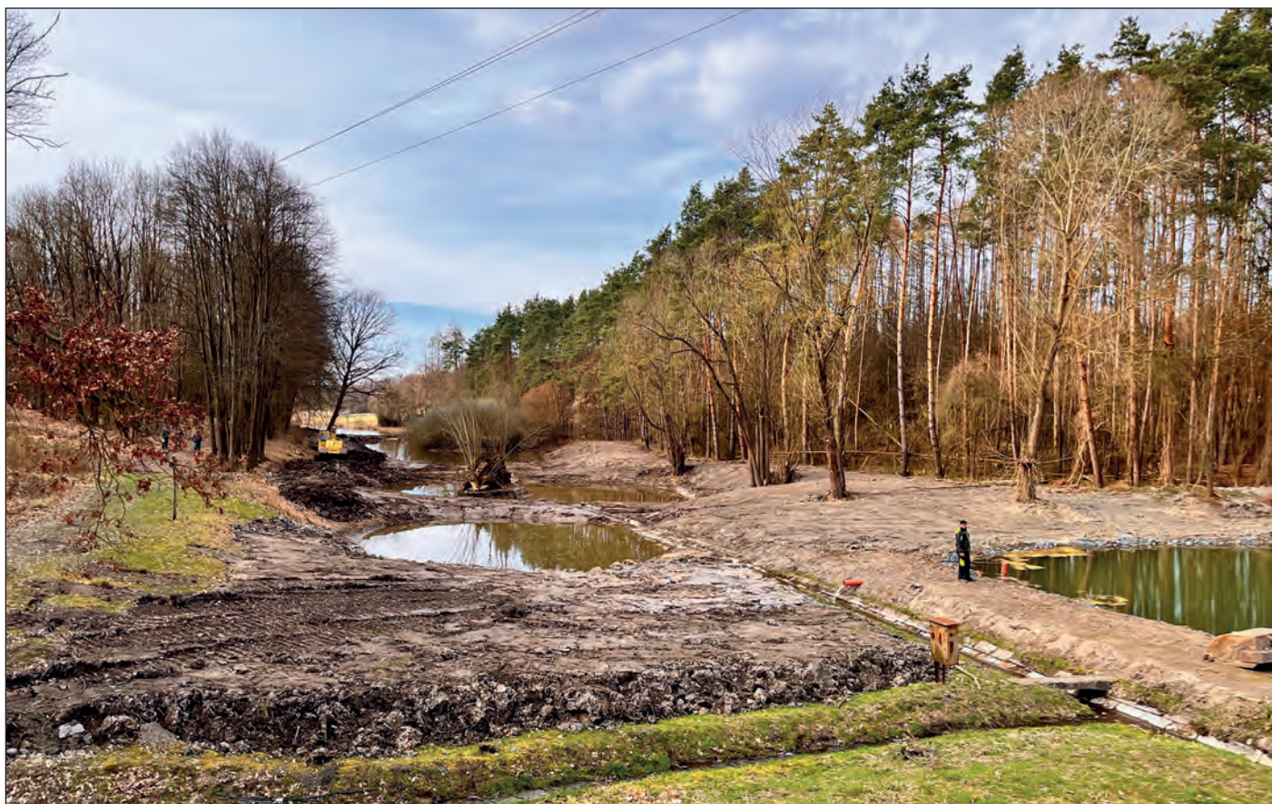
Od začátku roku probíhaly u Holských rybníků terénní úpravy zahrnující prohloubení a pročištění vodotečí a menších nádrží
