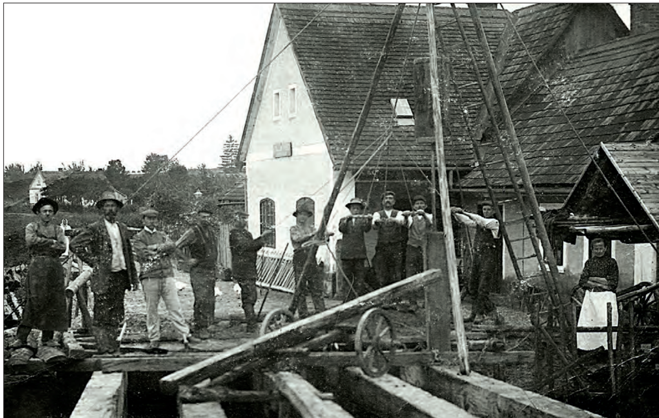
Stavba dřevěného mostu do Zámostí v roce 1909 (archiv města Rožďalovice)
