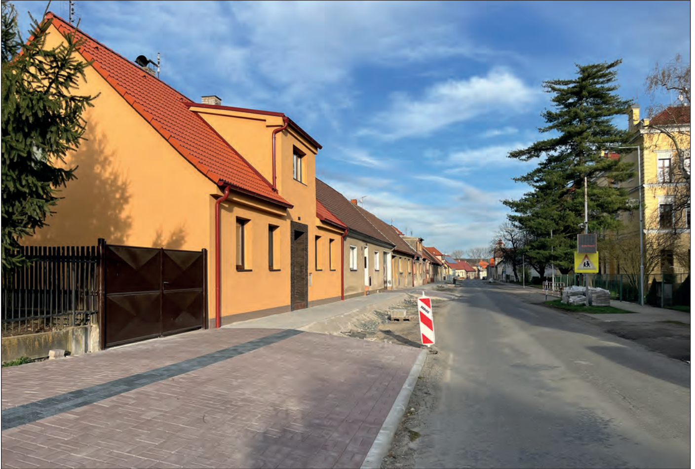
Od začátku roku pokračuje rekonstrukce chodníků v Tyršově ulici
