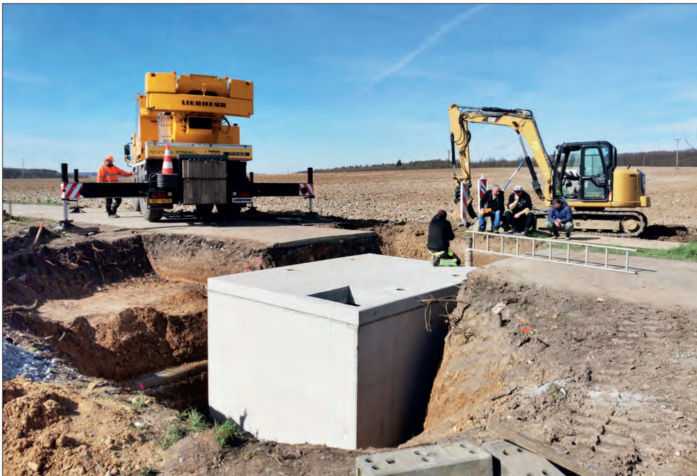
VaK Nymburk prováděl v pondělí 11. března v ulici U Fary stavební úpravy v souvislosti s připojením obce Košík na vodovodní řad
